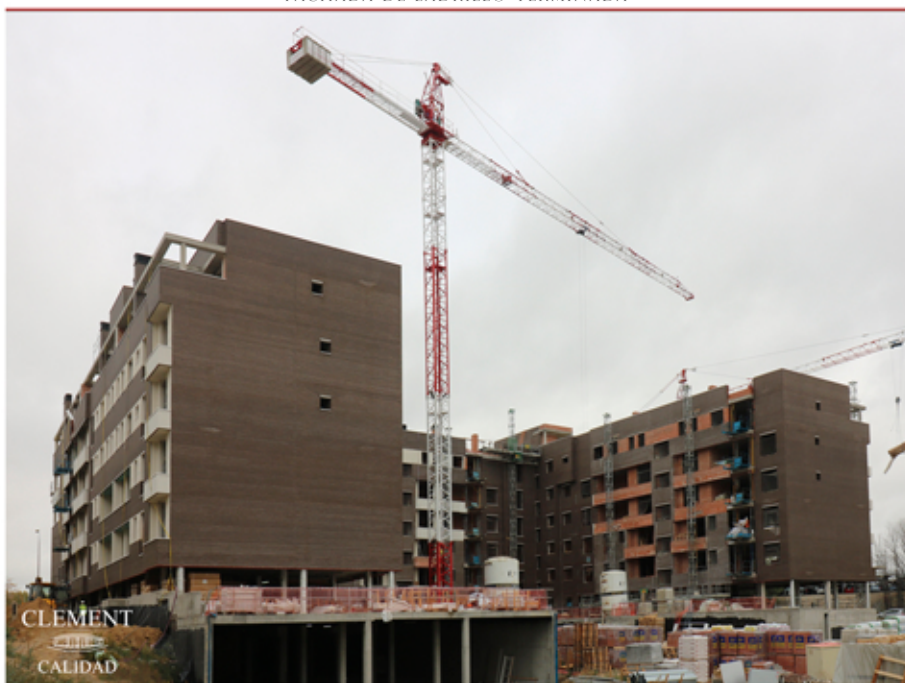
FACHADA DE LADRILLO TERMINADA
