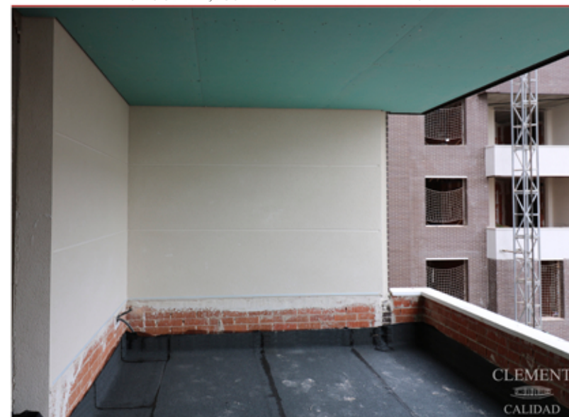
MONOCAPA EJECUTADO EN TERRAZA DEL PORTAL 4
