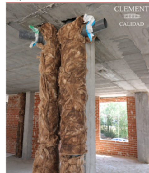
BAJANTES CON EL AISLAMIENTO COLOCADO
