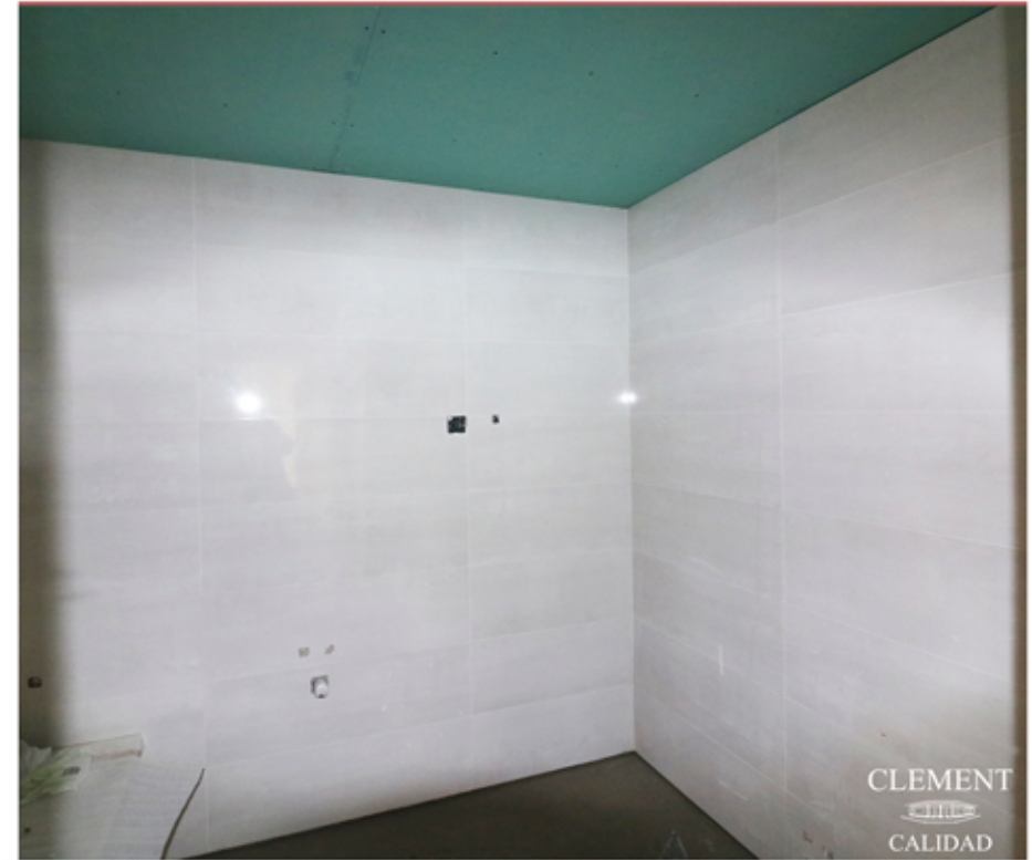
BAÑO ALICATADO Y CON FALSO TECHO COLOCADO
