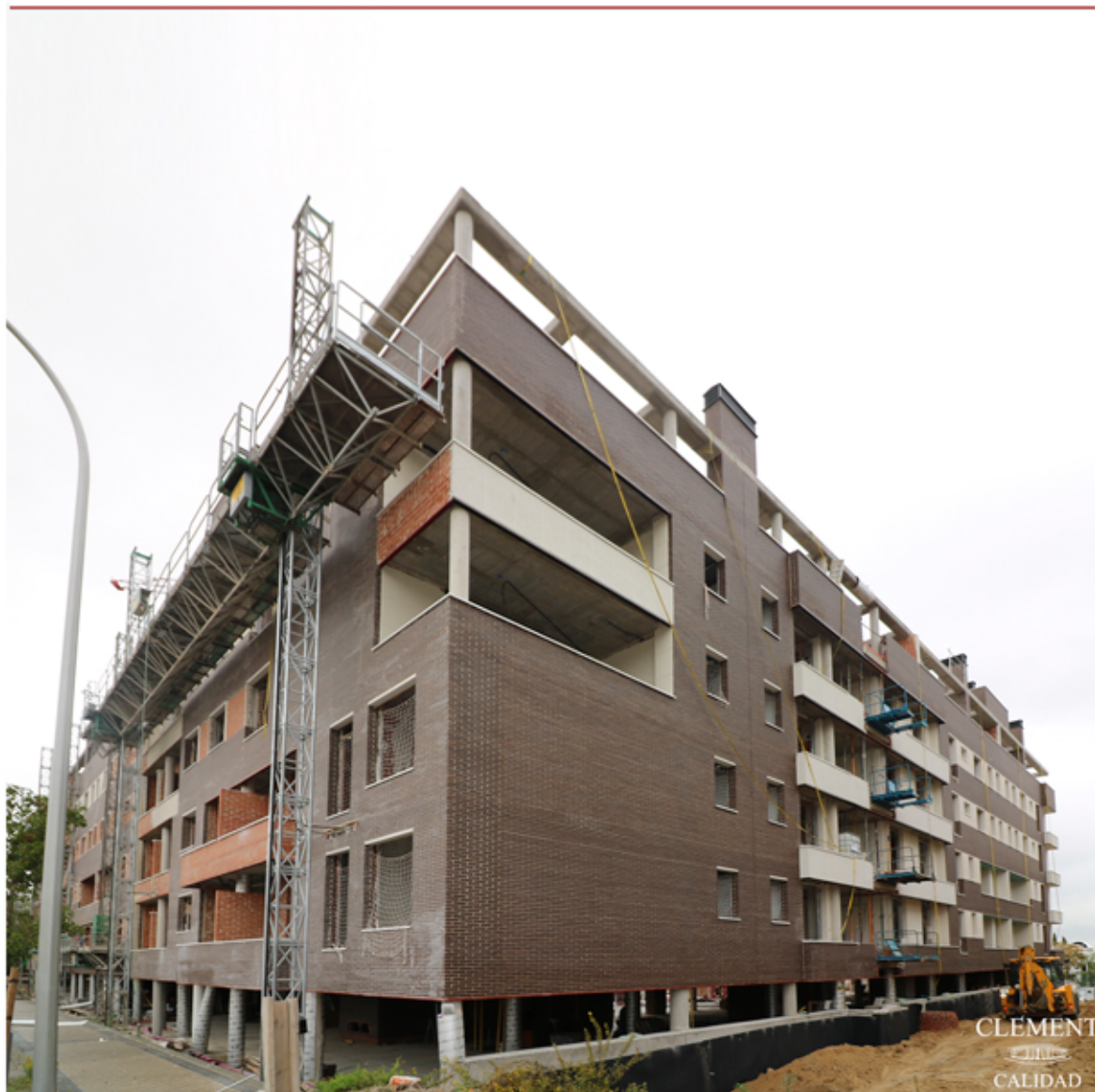
VISTA DE FACHADAS EXTERIORES DESDE PORTAL 4
