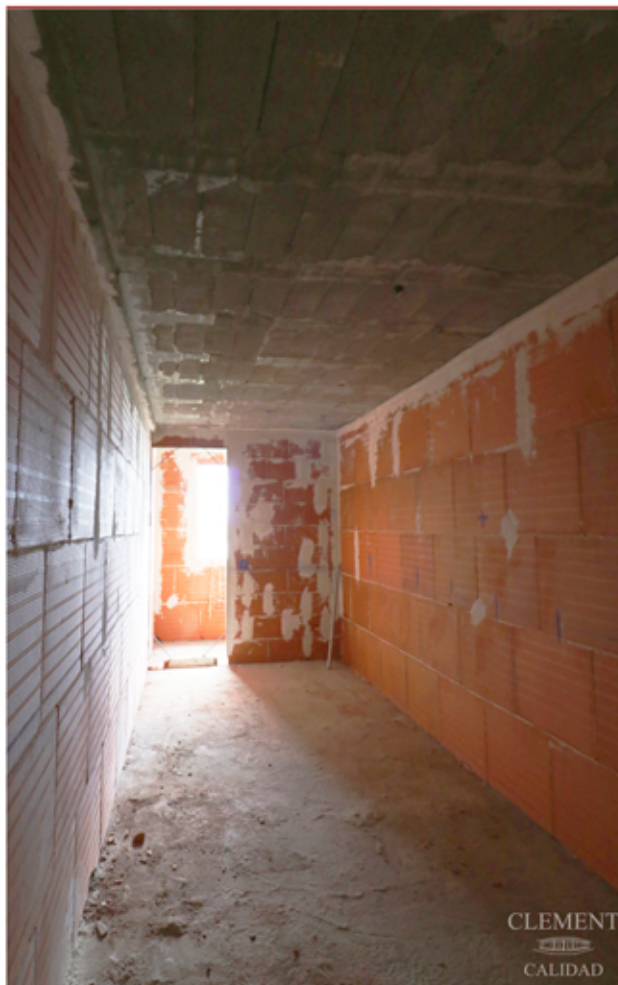
COCINA TABICADA EN VIVIENDA DEL PORTAL 2
