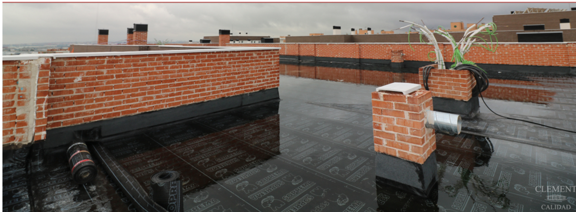
REALIZACIÓN DE LA PRUEBA DE AGUA EN CUBIERTA EN LA ZONA CORRESPONDIENTE A PORTAL 5 Y PORTAL 4
