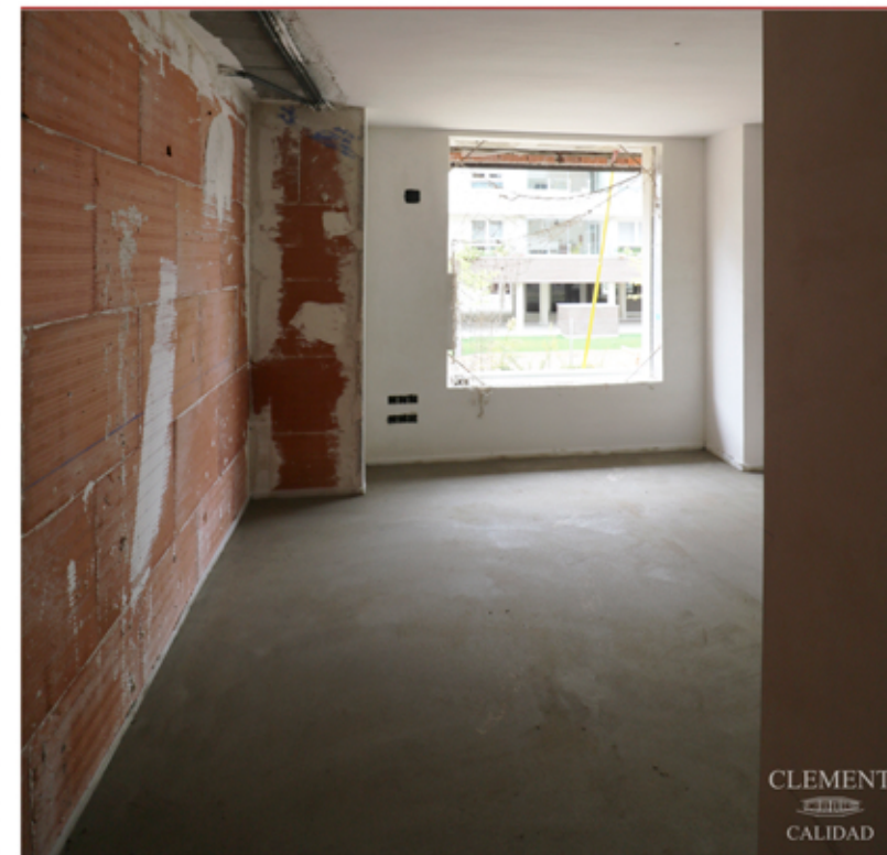
SOLERA DE MORTERO FINALIZADA EN DORMITORIO DE PORTAL 5
