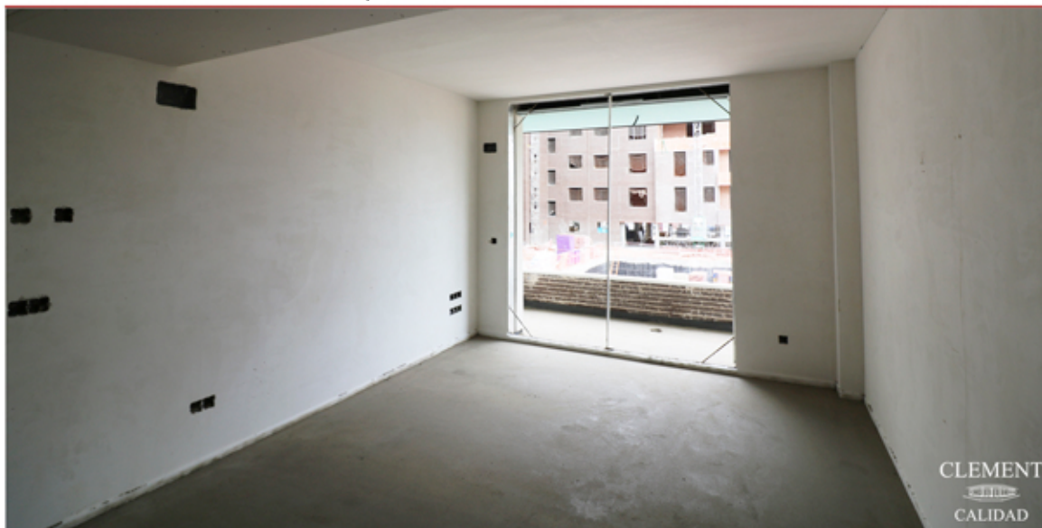
PLASTÓN EJECUTADO EN SALÓN DE VIVIENDA DE PORTAL 5
