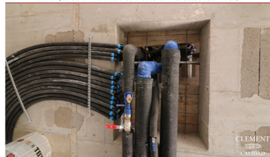
ARRANQUE DE UN PATINILLO DE INSTALACIONES DESDE PLANTA BAJA
