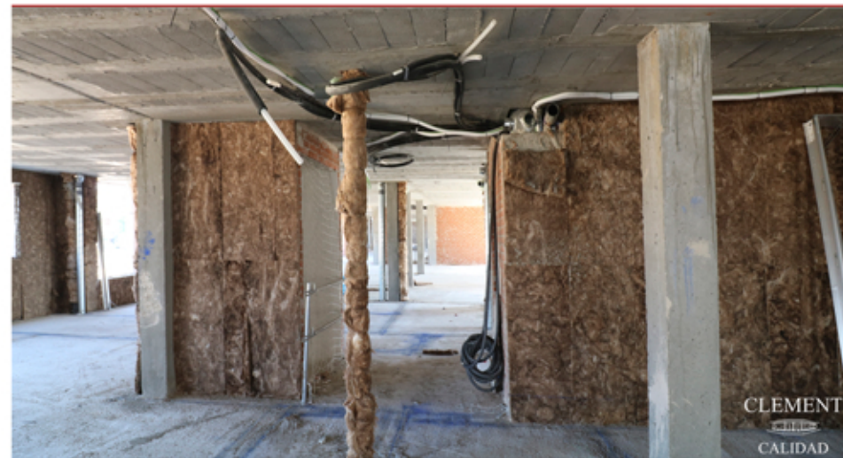
AISLAMIENTO COLOCADO ALREDEDOR DE ASCENSOR Y ESCALERA EN VIVIENDA DEL PORTAL 4
