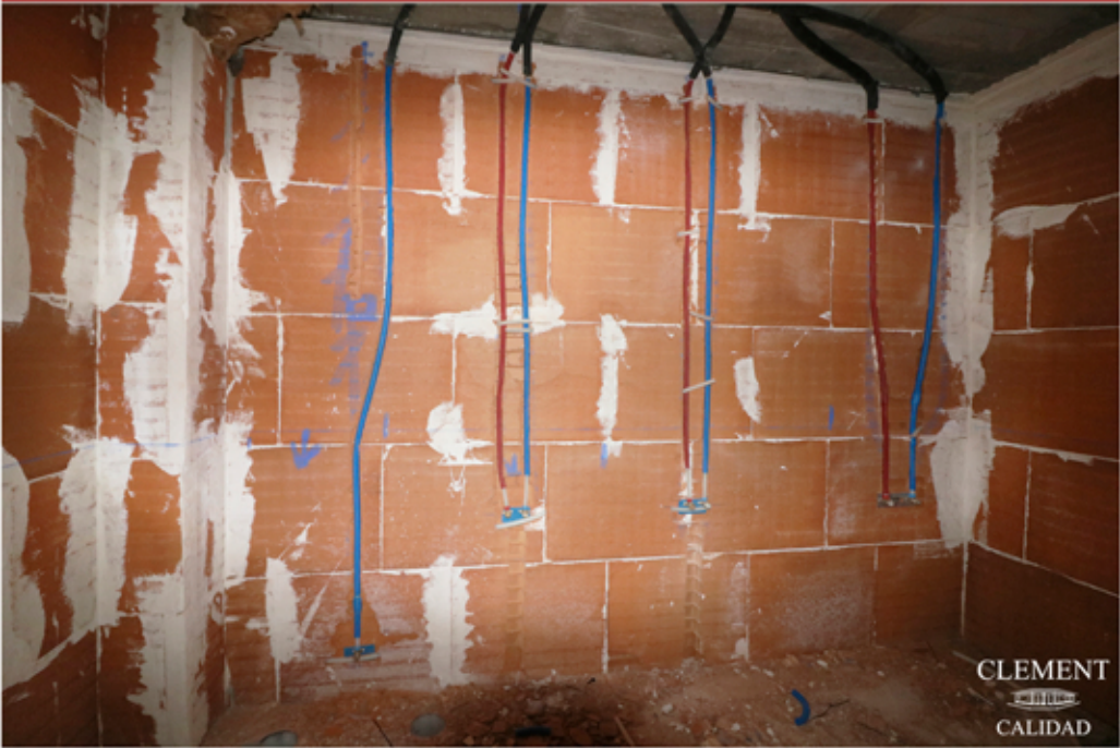
INSTALACIÓN DE FONTANERÍA EN UN BAÑO PRINCIPAL
