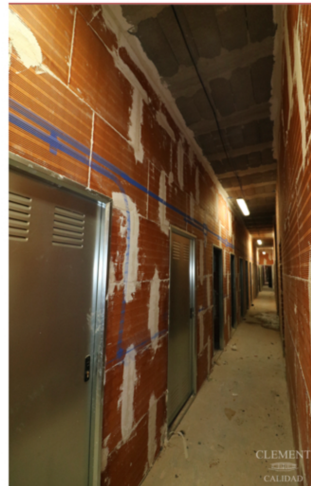
VISTA DEL PASILLO DE LOS TRASTEROS
