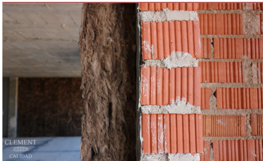
LA CAPA DE AISLAMIENTO LA FORMAN PANELES DE 10 CM DE ESPESOR
