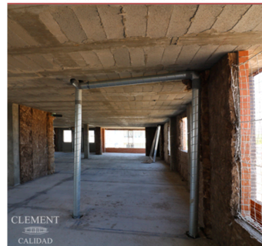
CONDUCTOS DE VENTILACIÓN
