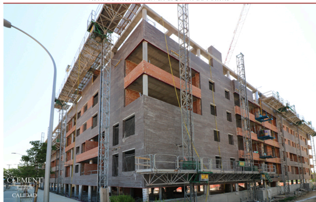
VISTA DE FACHADA EN LA ESQUINA DE PORTAL 4
