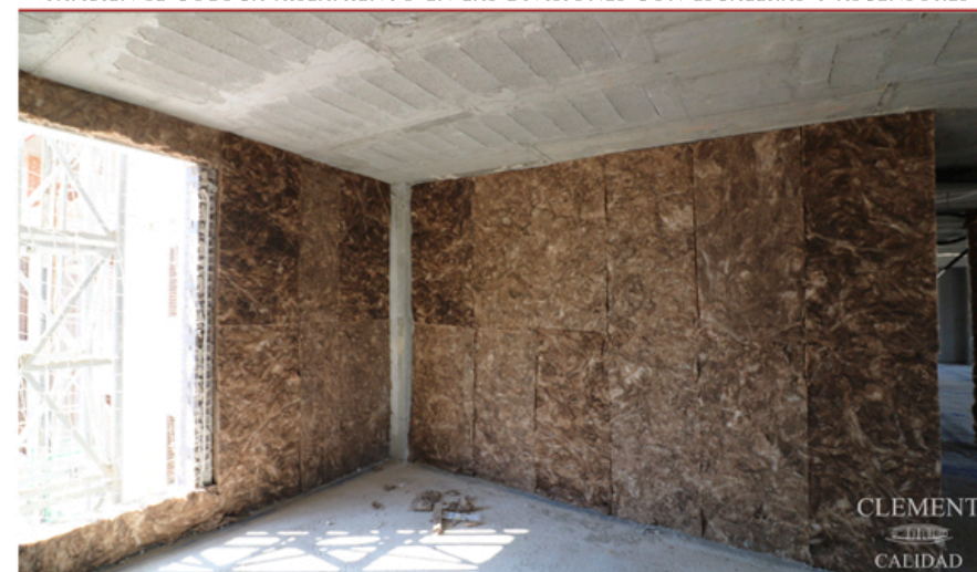
DETALLE DE LA LANA VOLCÁNICA COLOCADA EN UNA ZONA DE VENTANA
