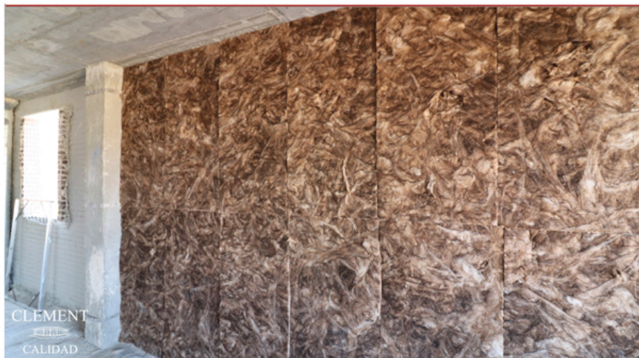
LA CAPA DE AISLAMIENTO LA FORMAN PANELES DE 10 CM DE ESPESOR
