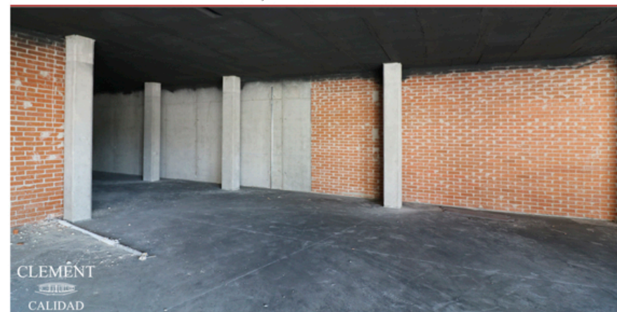
IMAGEN DEL GARAJE CON EL TECHO RECIÉN PINTADO
