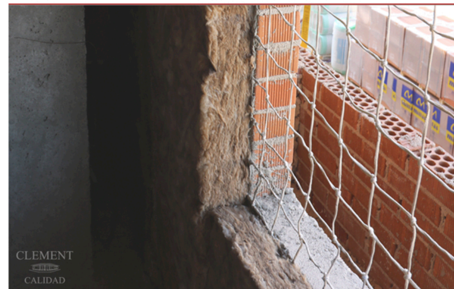
DETALLE DE LA LANA VOLCÁNICA COLOCADA EN UNA ZONA DE VENTANA
