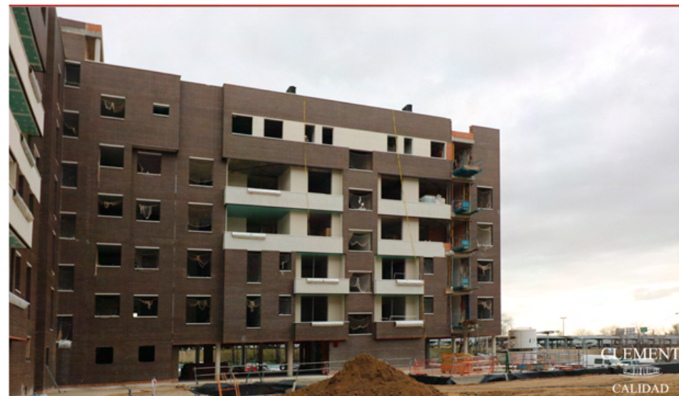
MONOCAPA EN FACHADA INTERIOR DE PORTAL 1
