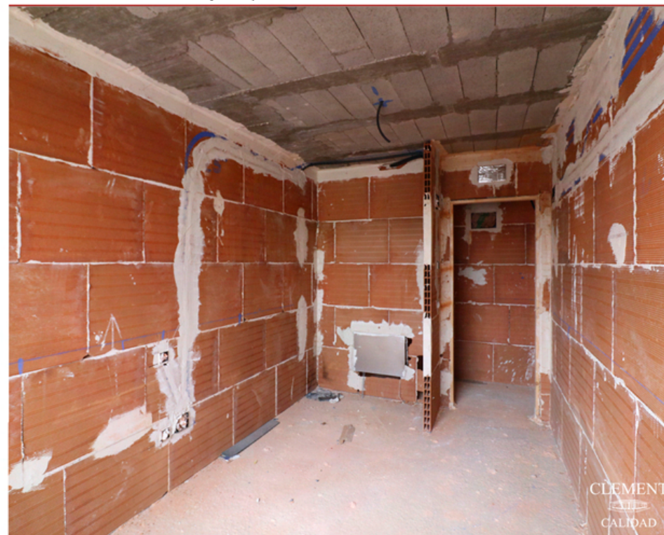
TABIQUES EJECUTADOS EN VIVIENDA DE PORTAL 1
