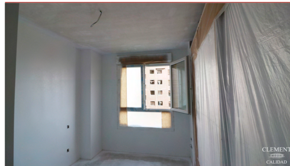
PRIMERAS MANOS DE PINTURA EN DORMITORIO DE VIVIENDA DE PORTAL 5
