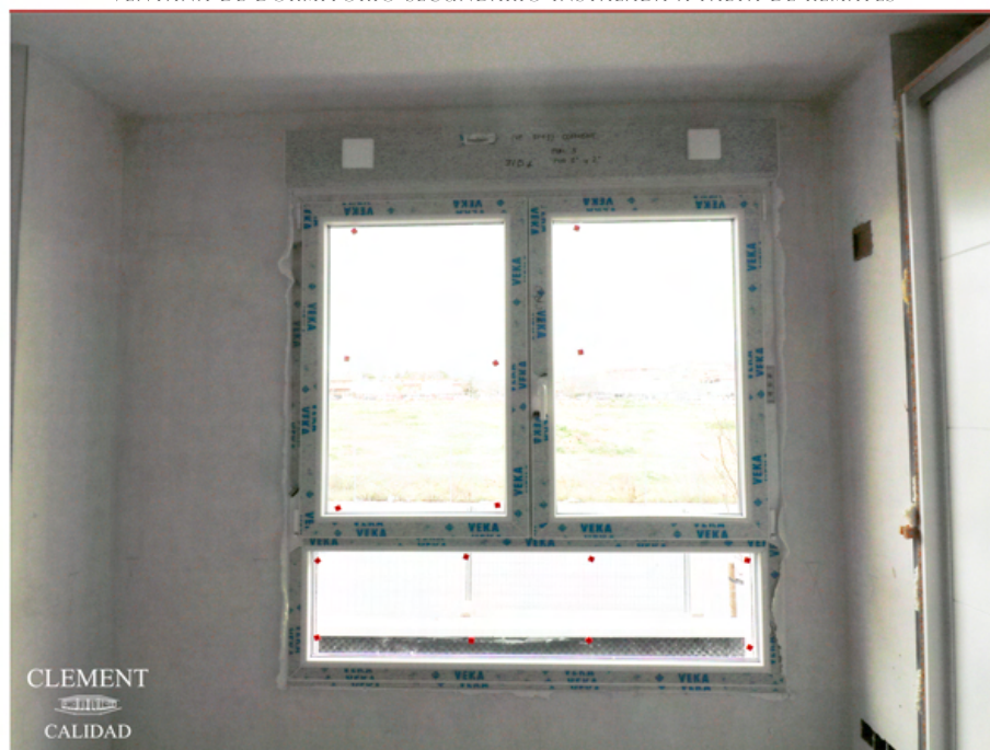
VENTANA DE DORMITORIO SECUNDARIO INSTALADA A FALTA DE REMATES
