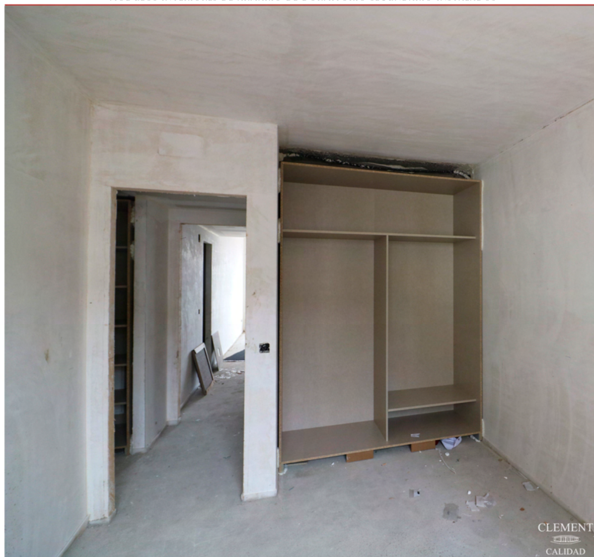
MÓDULOS INTERIORES DE ARMARIO DE DORMITORIO SECUNDARIO INSTALADOS
