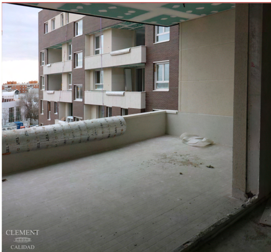
TERRAZA TERMINADA EN VIVIENDA DE PORTAL 3
