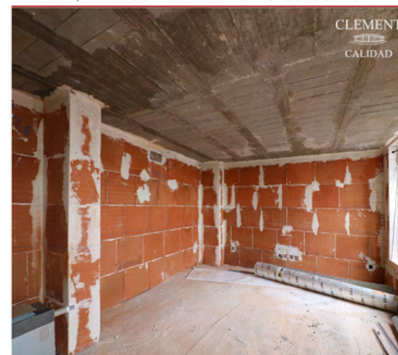
BAJANTES CON EL AISLAMIENTO COLOCADO
