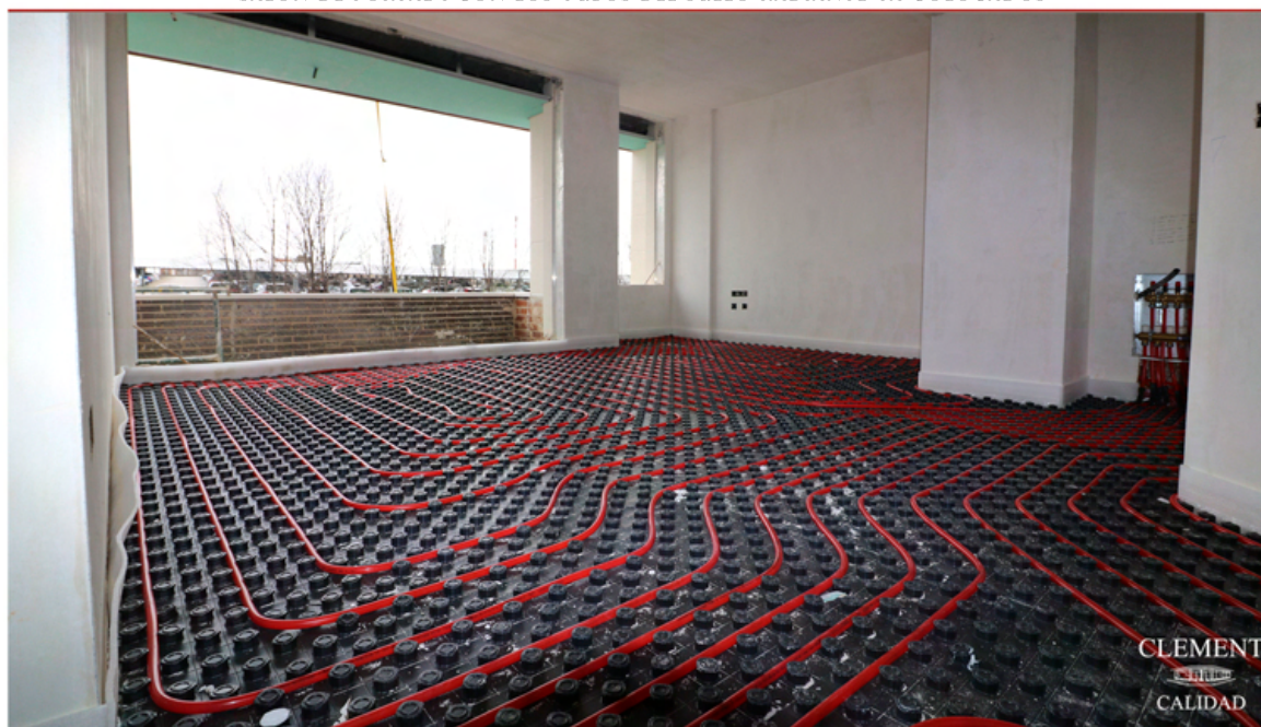
SALÓN DE PORTAL I CON LOS TUBOS DEL SUELO RADIANTE YA COLOCADOS
