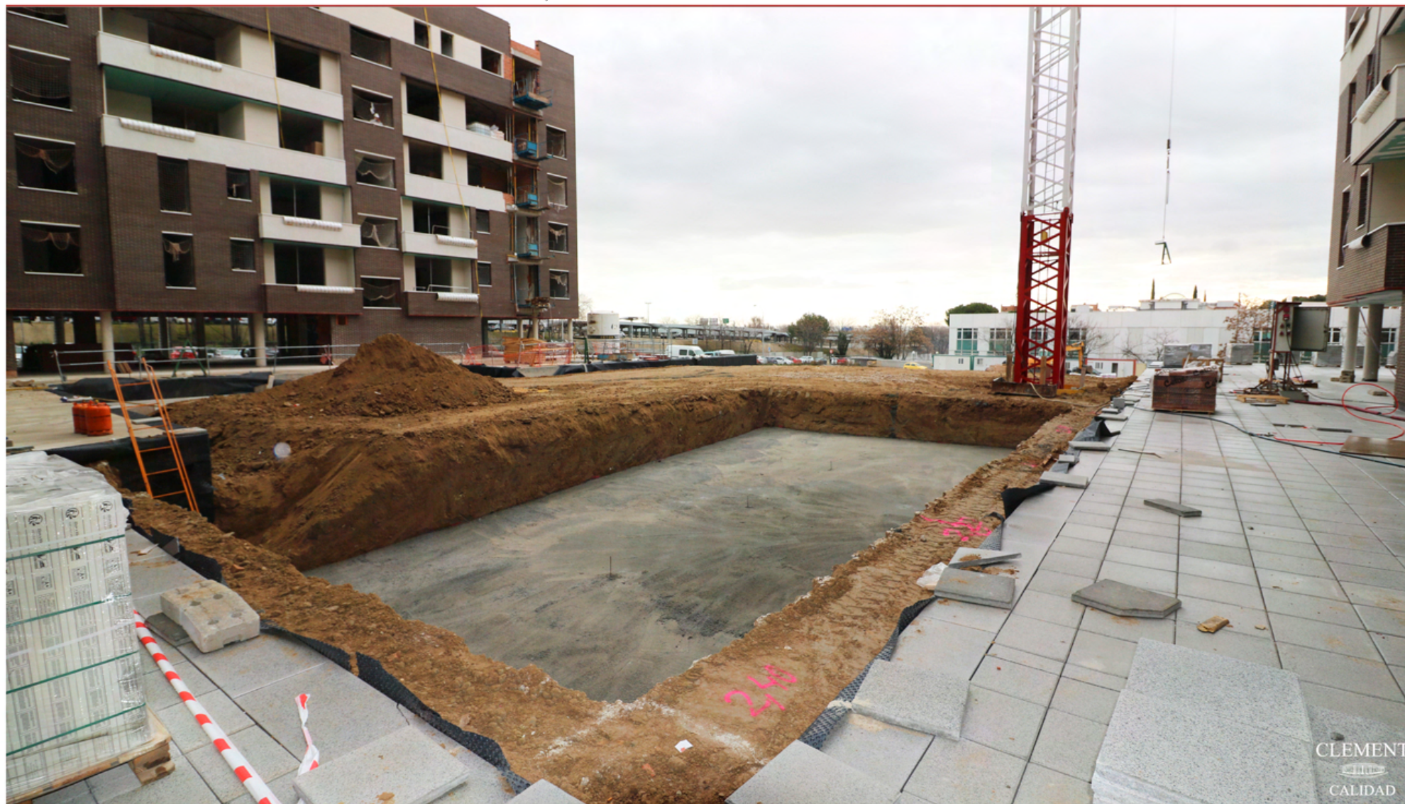
PRIMEROS TRABAJOS PARA LA CONSTRUCCIÓN DE LA PISCINA DE LA PROMOCIÓN
