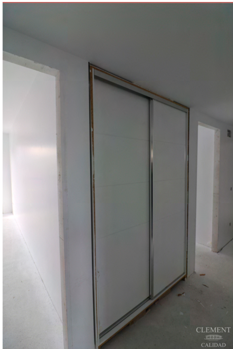
PUERTAS DE ARMARIO DE PASILLO INSTALADAS EN PORTAL 5
