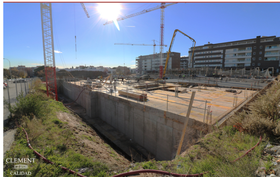
VISTA DE LA ZONA DEL PORTAL 2. 14/12/2018
