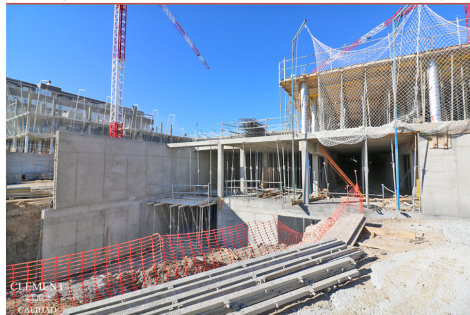
TRABAJOS EN LA ZONA DEL PORTAL I DONDE SE ENCONTRARÁ LA ENTRADA DEL GARAJE
