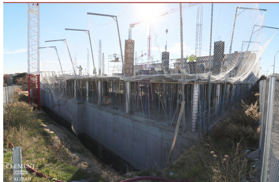
VISTA DE LA ZONA DEL PORTAL 2. 15/01/2019
