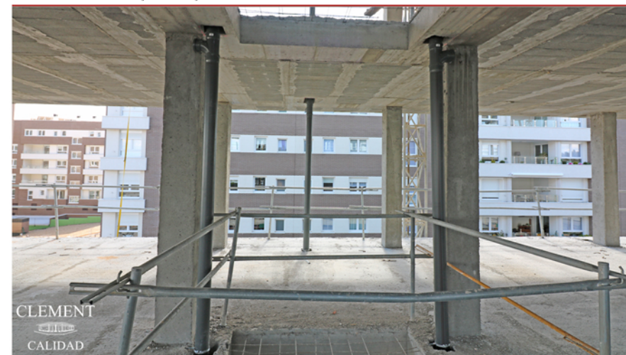
BAJANTES JUNTO AL HUECO DEL ASCENSOR DEL PORTAL 5
