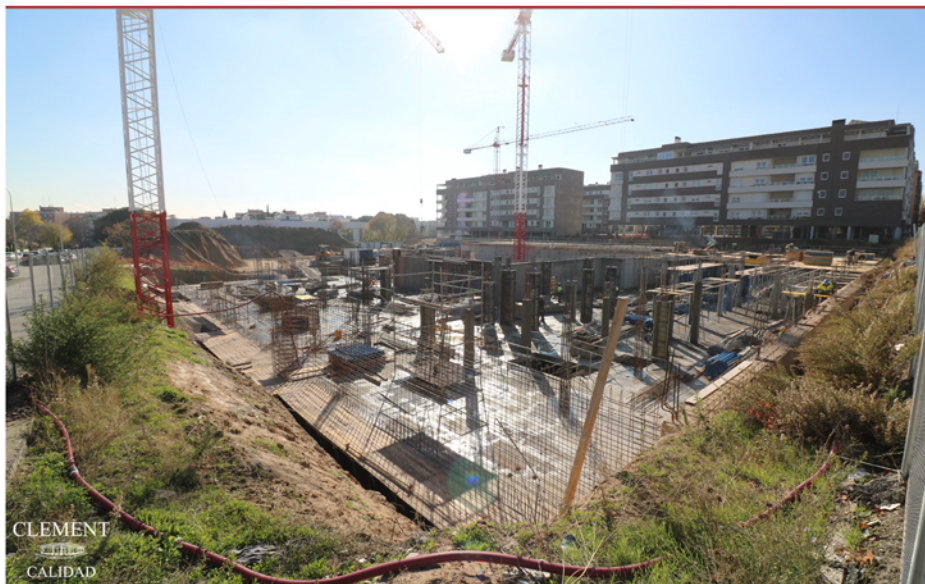
VISTA DE LA ZONA DEL PORTAL 2. 30/11/2018
