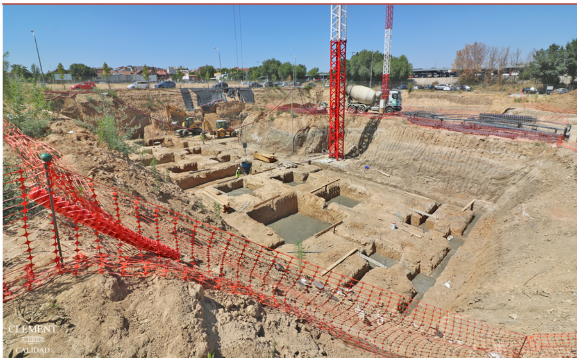
FASE DE EXCAVACIÓN Y HORMIGONADO DE ZAPATAS Y VIGAS DE ATADO. GRÚAS TORRE INSTALADAS
