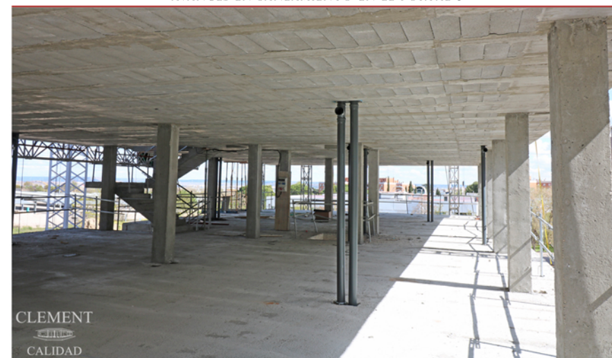
BAJANTES JUNTO AL HUECO DEL ASCENSOR DEL PORTAL 5
