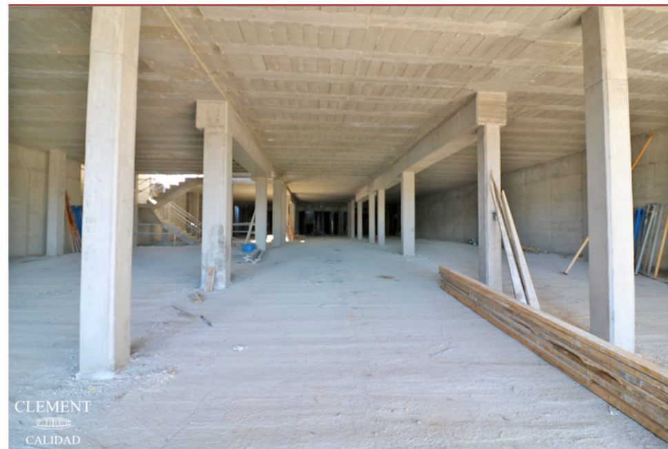
ESTRUCTURA FINALIZADA EN SÓTANO -1
