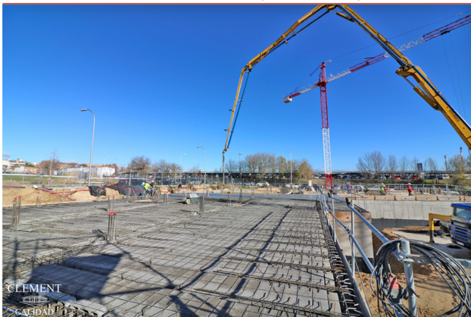
BOMBEO DE HORMIGÓN EN FORJADO DE PLANTA BAJA
