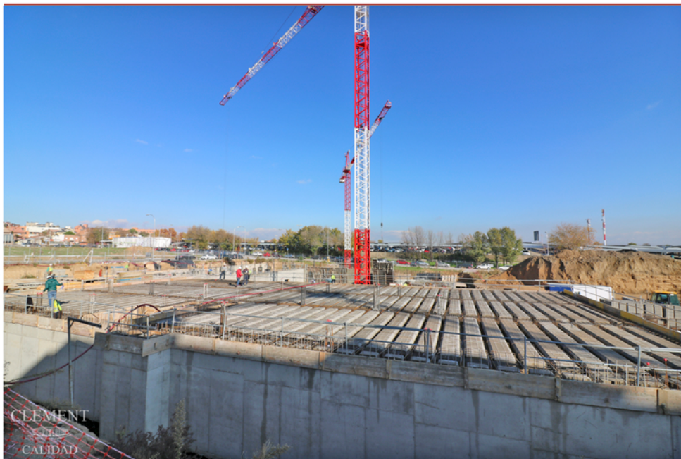
BOVEDILLAS DE HORMIGÓN COLOCADAS EN FORJADO DE PLANTA BAJA
