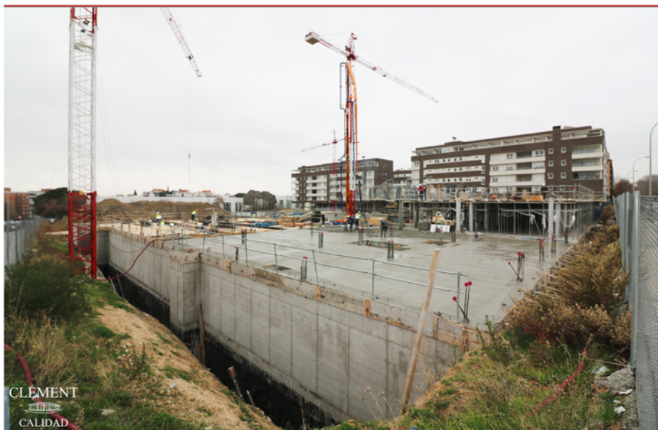
VISTA DE LA ZONA DEL PORTAL 2. 21/12/2018
