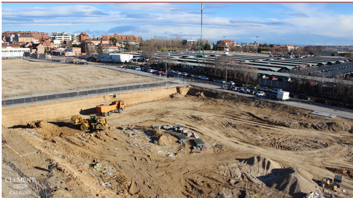
FASE DE EXCAVACIÓN Y HORMIGONADO DE ZAPATAS Y VIGAS DE ATADO. GRÚAS TORRE INSTALADAS
